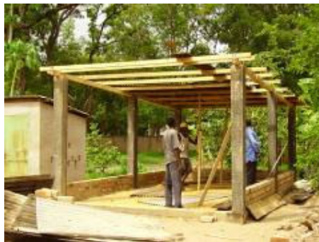
Finitions du hangar
