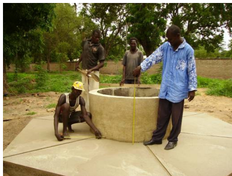
Finitions du puits
