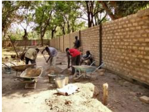
Travaux du mur
