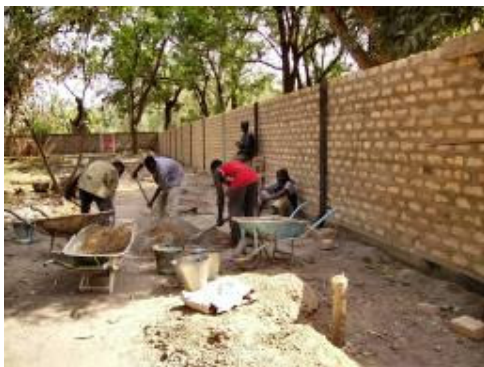
Les travaux du mur
